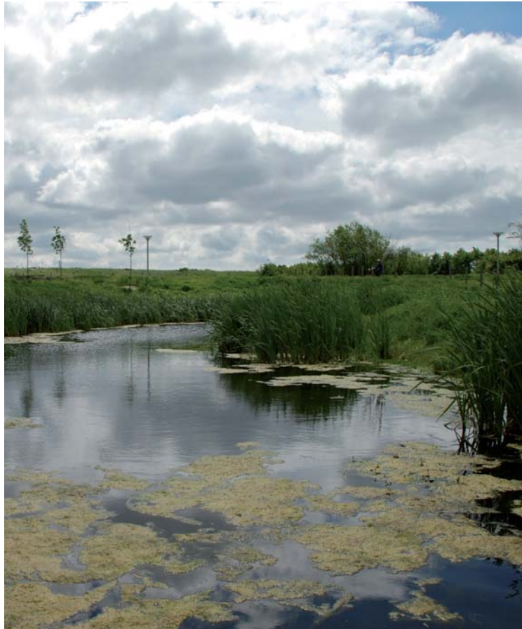
Regnvandsbassin i Hvissinge Øst. Bassinet kan opsamle store mængder regnvand og fungerer samtidig som et rekreativt element i byrummet.
