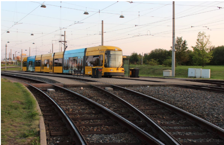
Eksempel på ballasterede spor, som anvendes på hovedparten af strækningen
