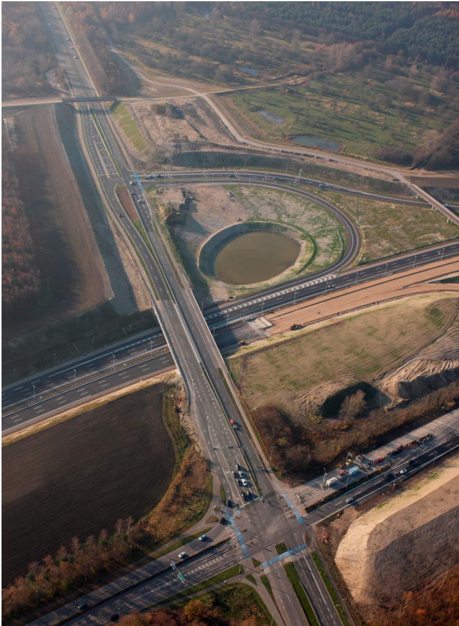
Vestskoven. Kryds med Jyllingevej
